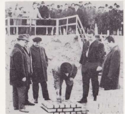
Grundsteinlegung Plattenwerk II
