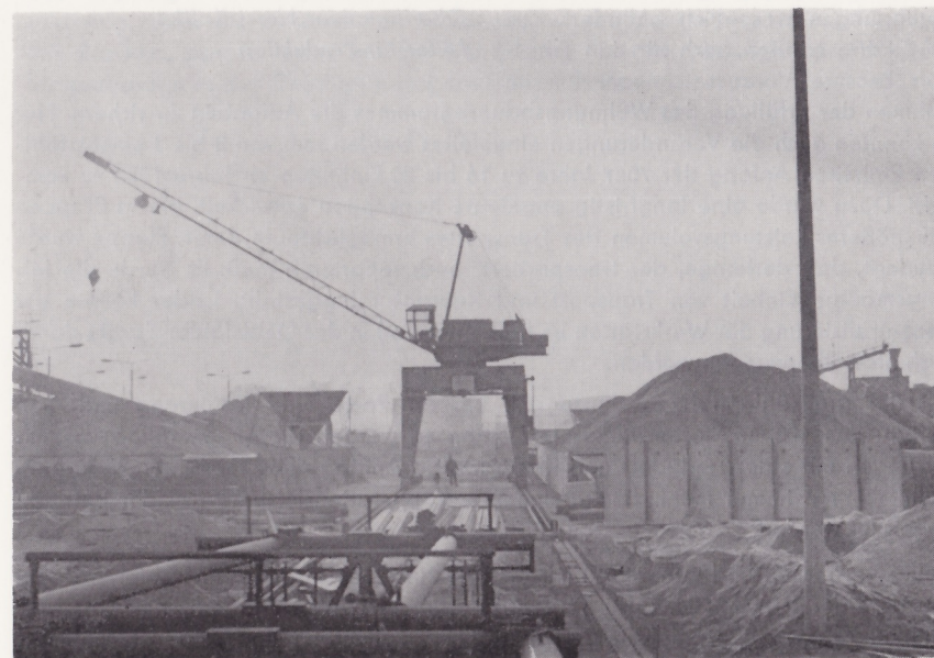
Erweiterung des Nordgleises für 2. PDK
