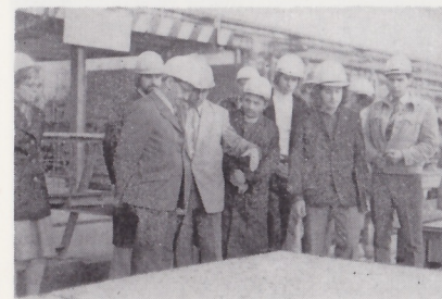
Inbetriebnahme Plattenwerk II
