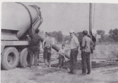
Erster Transportbeton zur Baustelle
