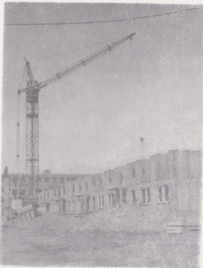
Montage mit 2 Mp-Elementen
